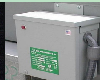
Installed KVAR PU-1200
